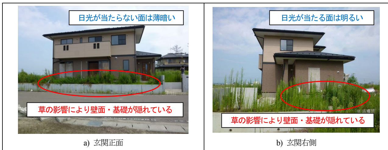
Fig.8 建物被害写真アップロードシステムを用いた全景写真（1）
