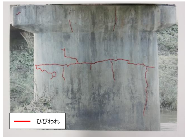
Fig. 23 橋梁点検の経験者 (C氏) による診断結果
