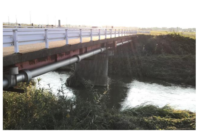
Fig. 7 本研究で撮影対象とした橋梁
