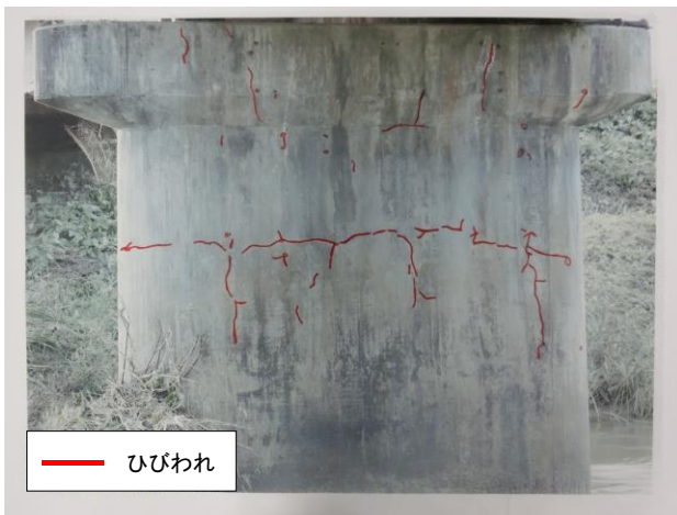
Fig. 22 橋梁点検の未経験者 (B氏) による診断結果
