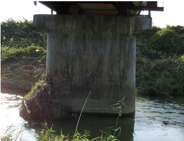
Fig. 13 デジタルカメラを用いて撮影した対象橋脚
