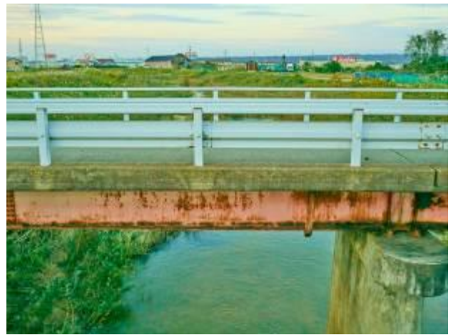
Fig. 11 実験対象橋梁の上部工の超高解像度写真 (UAVでの撮影)
