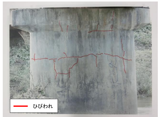
Fig. 24 橋梁点検の経験者 (D氏) による診断結果
