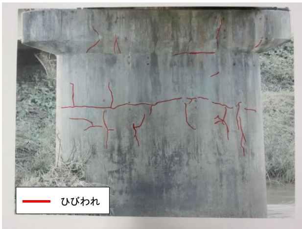
Fig. 21 橋梁点検の未経験者 (A氏) による診断結果
