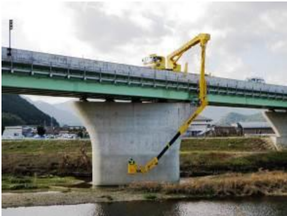
Fig.3 橋梁点検車による橋脚の点検 14)
