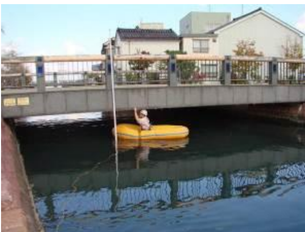
Fig.4 ボートを活用した近接目視による点検 15)
