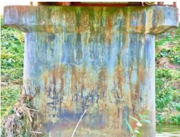
Fig. 10 実験対象橋梁の橋脚の超高解像度写真 (テーブル上での撮影)
