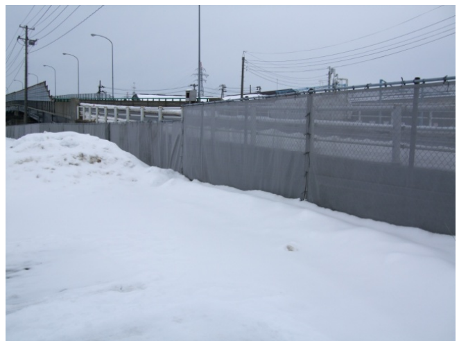
Photograph 8 宝町集積所に敷設のごみ飛散防止ネット
