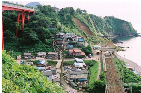
Photograph 10 JR 青海川駅裏斜面の家屋, 亀裂箇所にブルーシート (2007年7月19日撮影)
