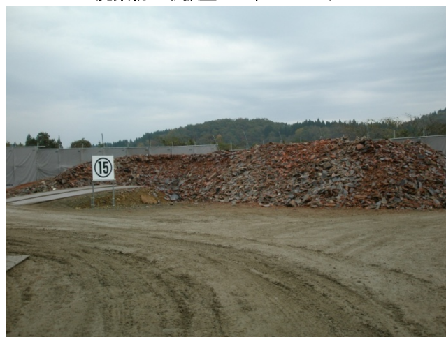
Photograph 14 集積所に仮置き後、埋立処分される屋根瓦（刈羽村）
