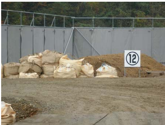
Photograph 16 油田地区集積所に敷設の防音性の高い飛散防止ネット(2007年11月10日)
