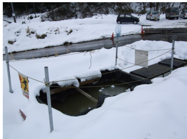
Photograph 18 同地区集積所に敷設された集水槽
