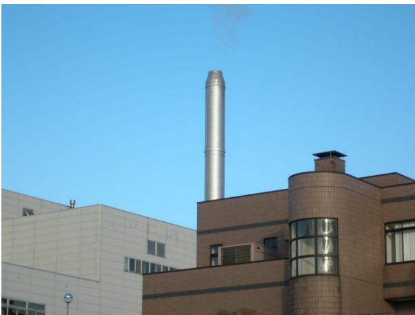
Photograph 3 仮設煙突敷設（2007年11月28日撮影）
