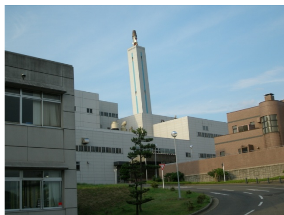
Photograph 1 クリーンセンターかしわさきの被災状況 (2007年7月19日撮影)
